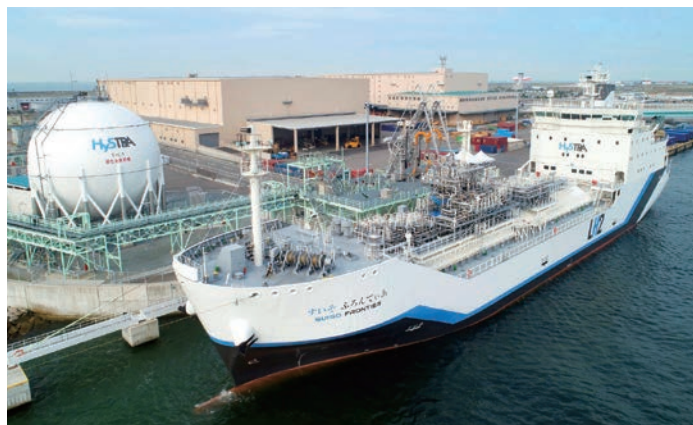
当社が運営する神戸空港島の液化水素輸入基地に接岸する液化水素運搬船「すいそふろんていあ」
