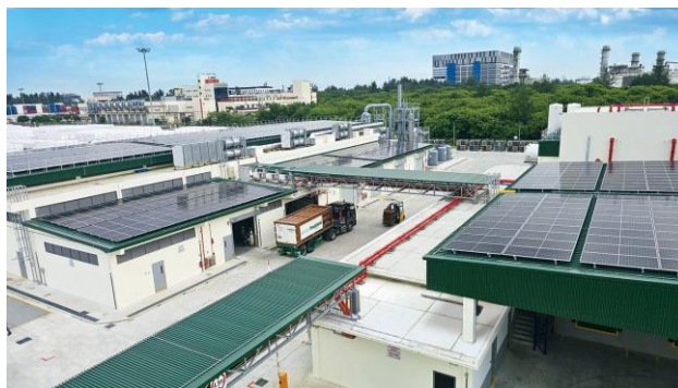
新たに開設したガスセンター
