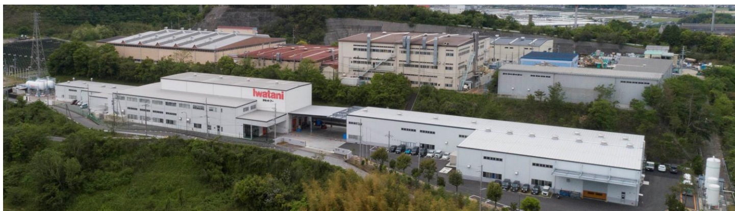
▲左がカセットボンベの充填工場、右が新設の製缶工場
