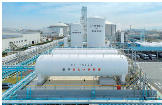
液化水素ガスやセパレートガスなどを製造する「ハイドロエッジ」
