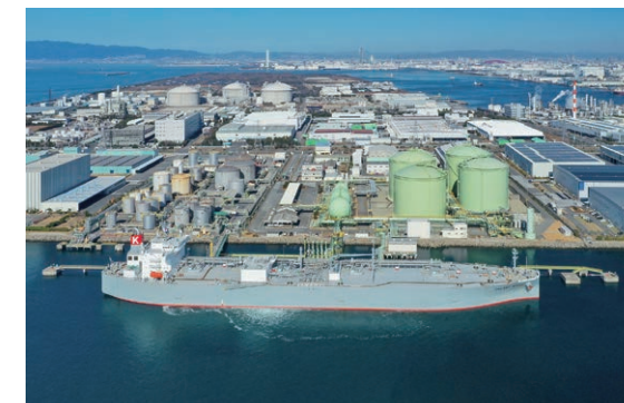
LPガス輸入基地「堺ターミナル」
