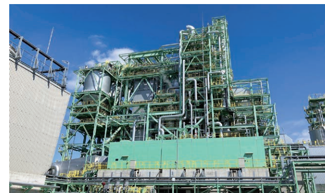
2025年4月に営業運転を開始した田原バイオマス発電所
