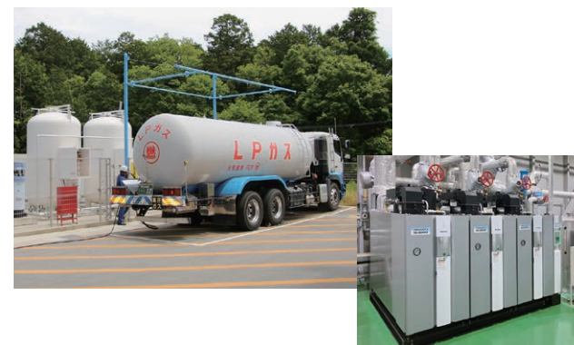
既存の油焚きからガス高効率ボイラへの燃料転換を推進
