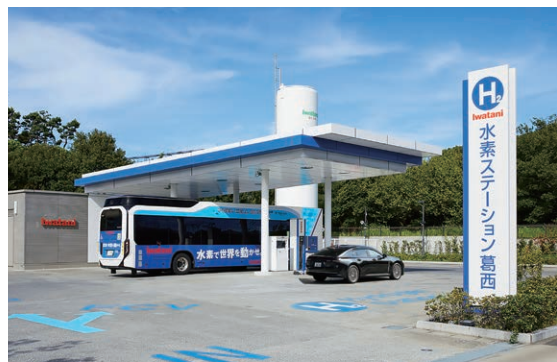
需要拡大が見込まれる燃料電池商用車向け水素ステーション事業に注力
