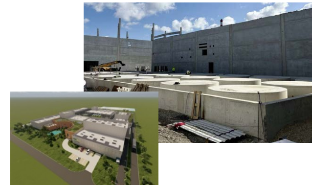
レアアース生産に向けて建設中のカレマグ社と完成イメージ
