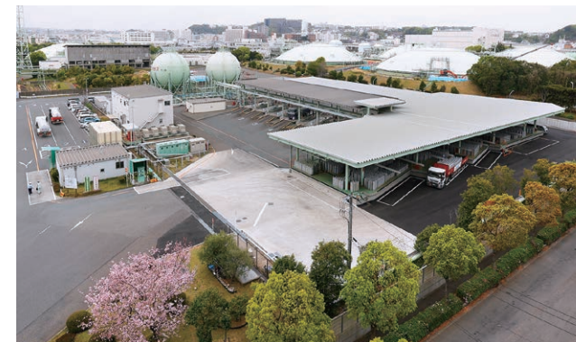
根岸液化ガスターミナル
