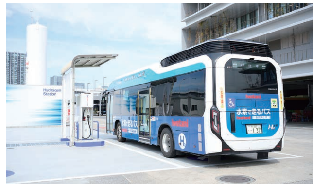
国内初、バス営業所内で運営する水素ステーション
