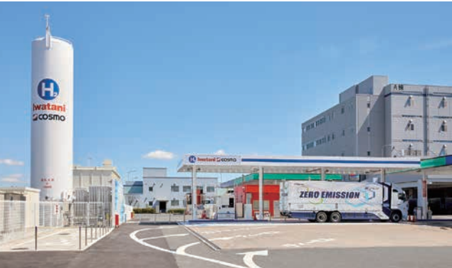
燃料電池大型トラックに対応した「岩谷コスモ水素ステーション平和島」
