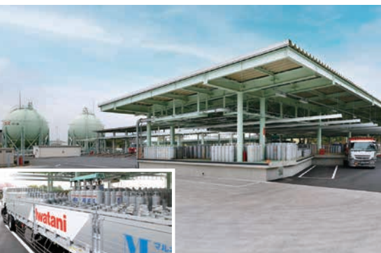
大型トレーラーによるシリンダー大量輸送の拠点となる「根岸液化ガスターミナル」
