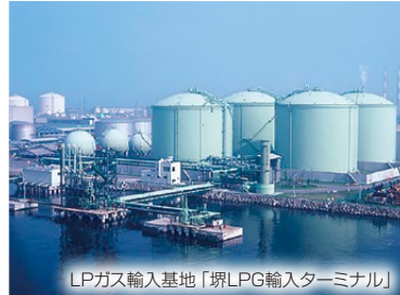
LPガス輸入基地「堺LPG輸入ターミナル」
