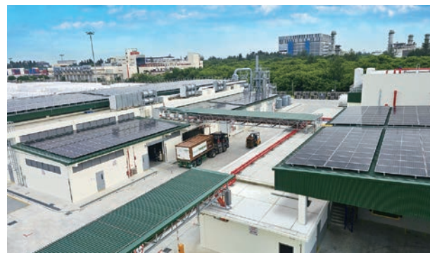
シンガポール・ジュロン島に新設した総合ガスセンター
