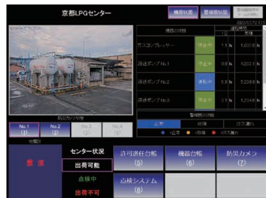
カメラを利用したセンター保安システムによる被災状況の確認
