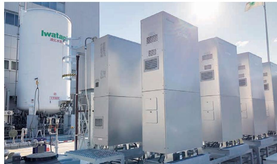
中央研究所に導入した純水素型燃料電池(5kW×20台)
