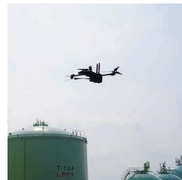
ドローンを活用した工場巡視点検
