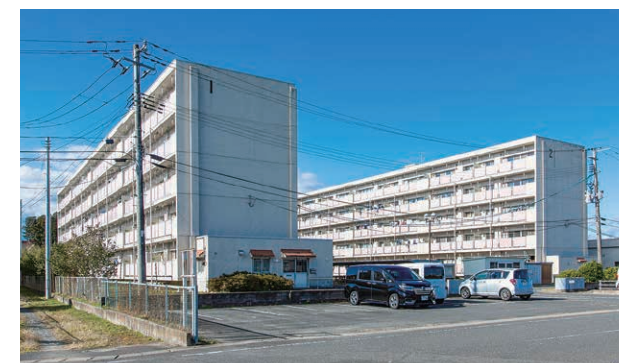
水素混合LPガス導管供給実証を行う南相馬市定住促進住宅（80戸）
