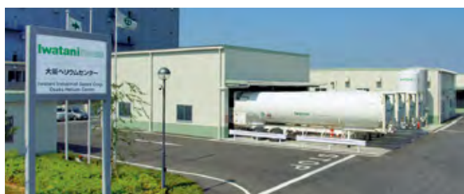
ヘリウム供給拠点(ヘリウムセンター)
