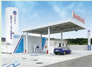
水素ステーション関連設備
