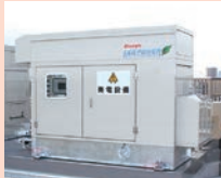
LPガス非常用発電機
