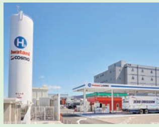
岩谷コスモ水素ステーション平和島
