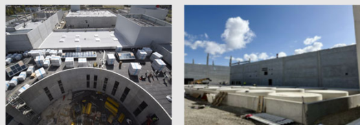
カレマグ社 レアアース精錬工場（建設中）
