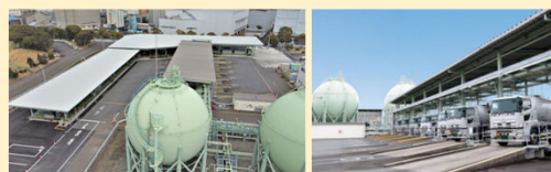
根岸液化ガスターミナル
