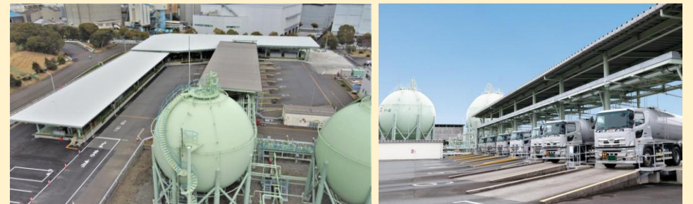
根岸液化ガスターミナル
