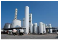
エアセパレートガス製造プラント (中国・嘉興市)
