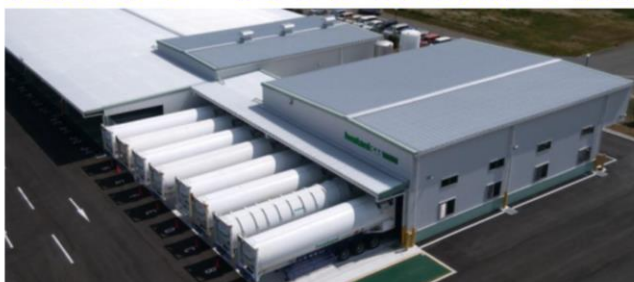
東京ヘリウムセンター（新設）
