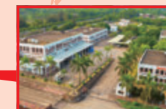
Iwatani Gas Appliances (Zhuhai) Co., Ltd.
