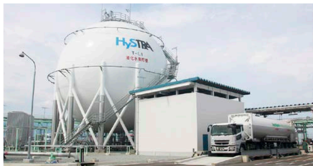
神戸空港島に完成した液化水素貯蔵・揚荷施設
