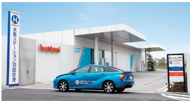
イワタニ水素ステーション 羽田空港
