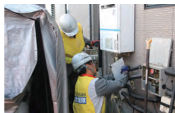
ガス機器の点検、修繕
