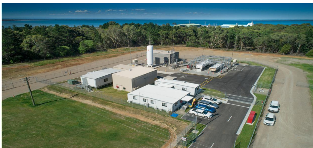
水素液化・積荷基地
