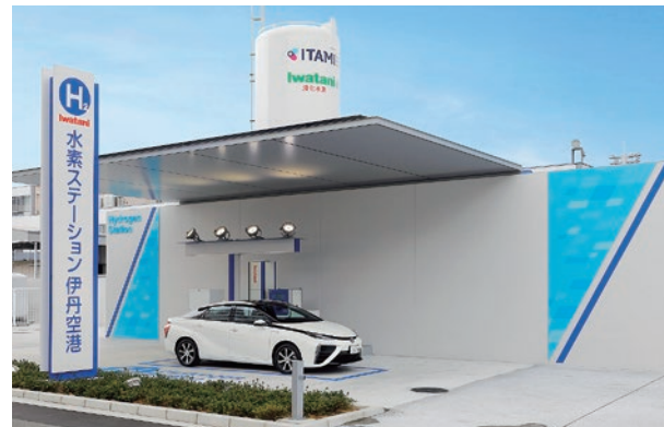
伊ワタニ水素ステーション 大阪伊丹空港
