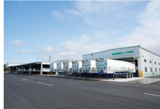
4月に稼動を開始した東京ヘリウムセンター
