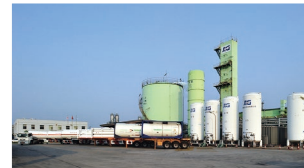
新プラントを建設中の嘉興岩谷気体会社
