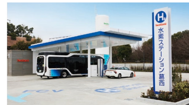
東京都江戸川区に完成した「イワタニ水素ステーション 東京葛西」
