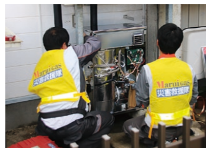
宮城県柴田郡で復旧活動を行うMaruigas災害救援隊
