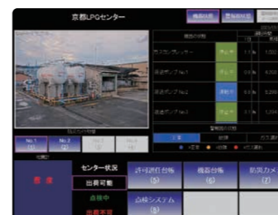
カメラを利用した保安システムによる被災状況の確認
