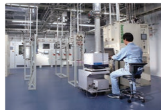
特殊高圧ガス実験室
