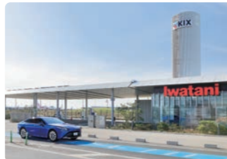
伊ワタニ水素ステーション 関西国際空港
