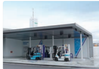
関西国際空港 産業車両用水素インフラ
