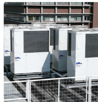
GHP(ガスヒートポンプエアコン)
