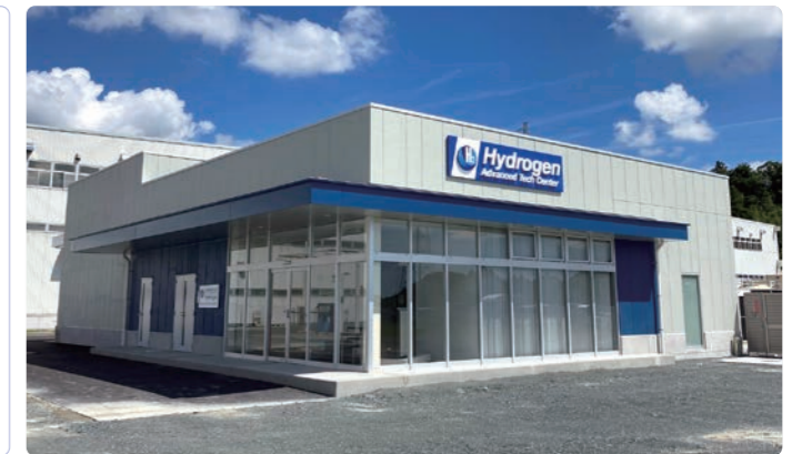
トキコシステムソリューションズ(株) 水素先端技術センター
