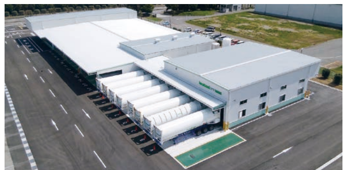
2019年4月に完成した東京ヘリウムセンター
