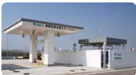
関西空港水素ステーション
