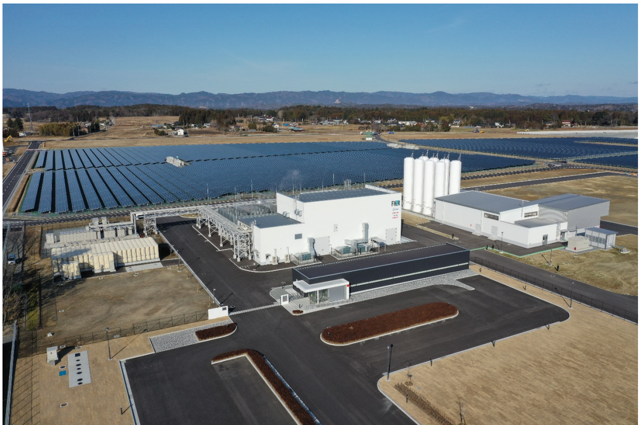
図1 完成した福島水素エネルギー研究フィールド(FH2R)
