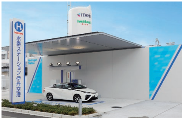
イワタニ水素ステーション 大阪伊丹空港
