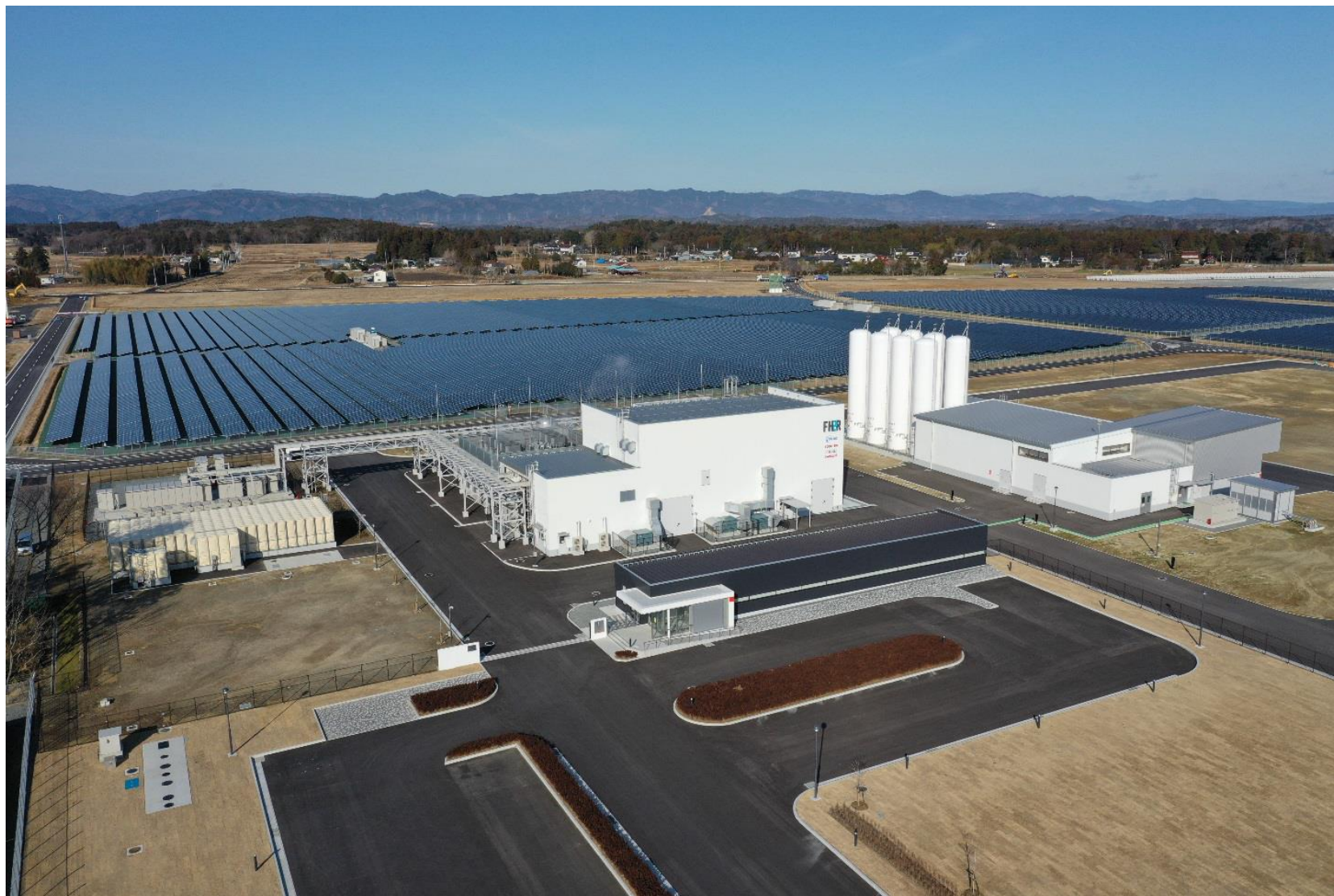
完成した福島水素エネルギー研究フィールド（F H 2 R）
